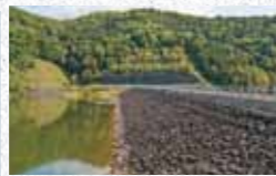
堤体を覆う岩（ロック材）が整然と敷き詰められているのが、よくわかる。
