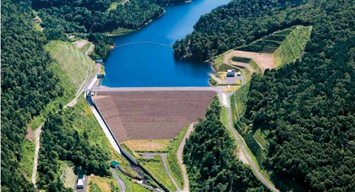
堤頂の長さは234m、堤体の高さは53.6mで13階建てのビルに匹敵する(写真提供/網走開発建設部)
