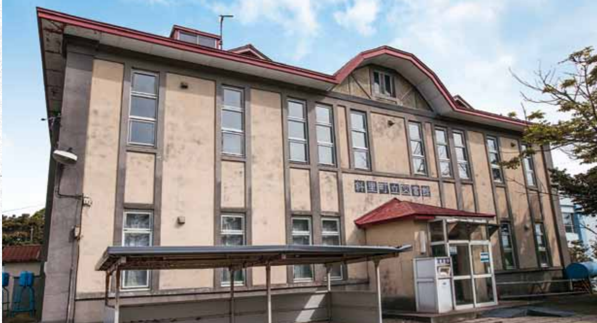
2014（平成26）年9月に閉館され、今後の活用・保存については、まだ決まっていない。
