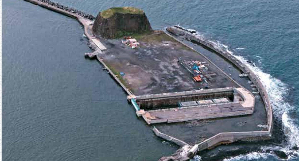
天然の岩盤をくり抜いた極めて珍しい構造である。(写真提供：網走開発建設部)
