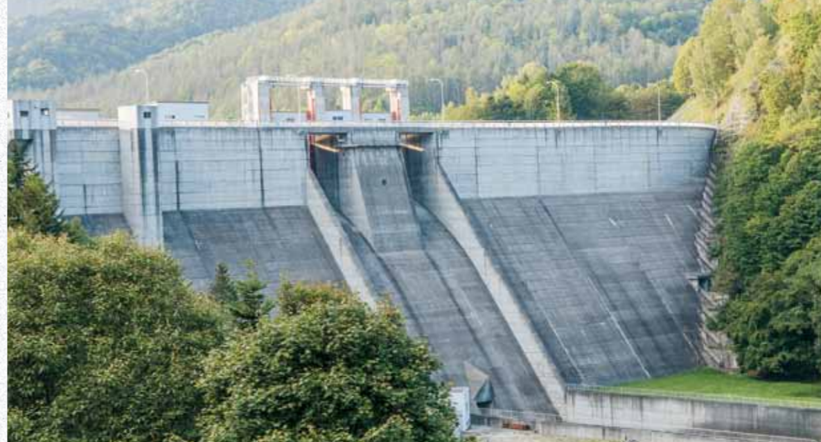
高さ 55.5m の重力式コンクリートダム。直線的な構造はモダンなデザインに感じる。
