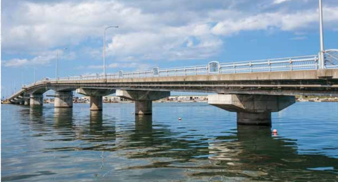
栄浦大橋は一般道路に架かる橋ではなく、漁港施設の一部という位置づけだ。
