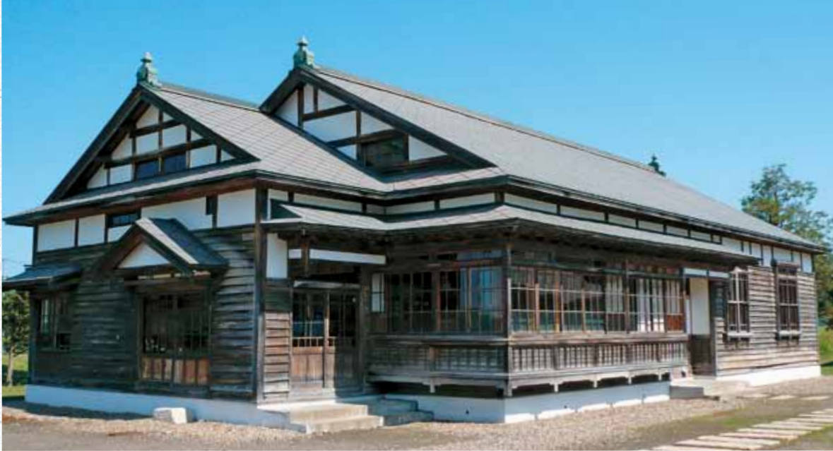
1937（昭和12）年、ハツカ商・五十嵐弥一の私邸として建てられた。1994（平成6）年に現在地に移築された。（写真提供：北見田園空間情報センター）
