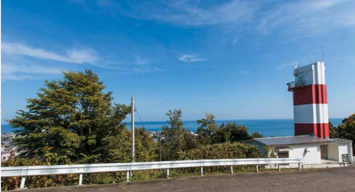
1960（昭和35）年に建築された紋別灯台。市街地の中に建つ灯台は、日本ではおそらくここだけだろう。
