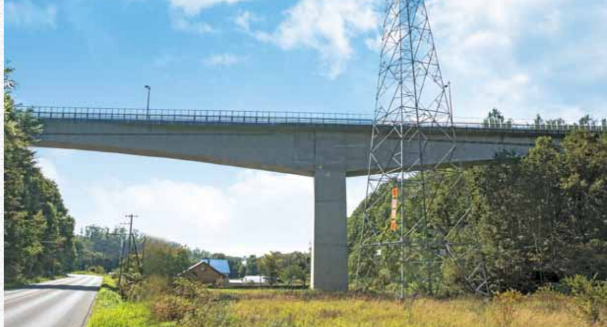
大正地区と昭和地区の間の谷を、直線的に横断する平成高架橋。
