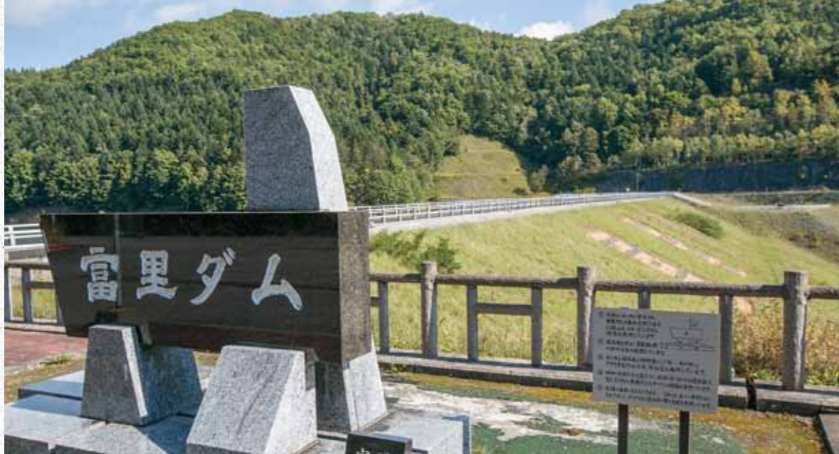
下流側の堤体には芝生が植えられ「富里ダム」の文字も描かれていて美しいダムと言える。
