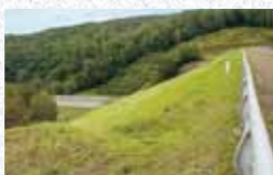
奥に見えるのが洪水吐からの導流部で、水平部分が長い。その先はスキージャンプ式で放水される。
