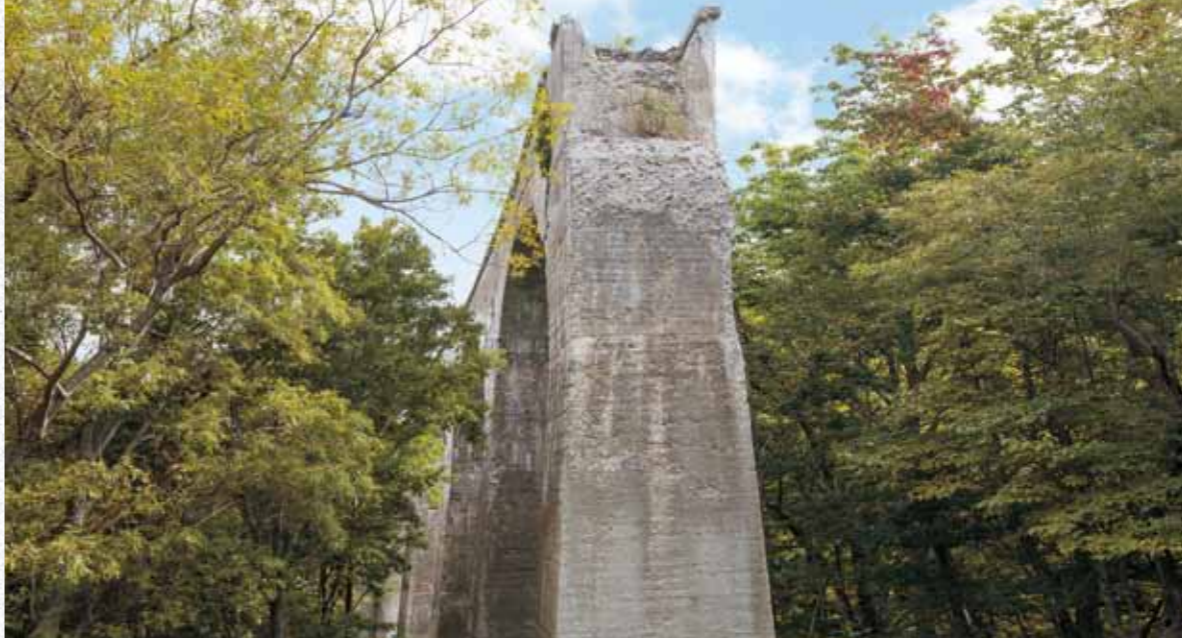
全長 147m、最大地上高 21.6m のコンクリート製アーチ橋で、当時の土木技術を伝えるものとして国の有形文化財に登録されている。
