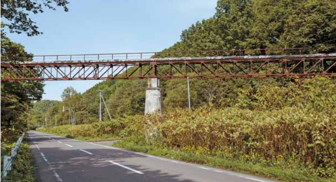
運行わずか5年ほどで廃止となった鴻紋軌道。道道305号線をまたぐ五号杭橋は鉱山水送水施設として現在も活用されている。
